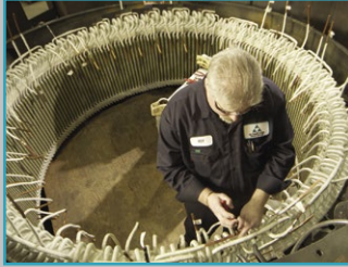
PowerSeal™ VPI Rewind
