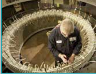
PowerSeal™ VPI Rewind
